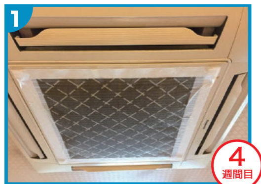
エアコンフィルター 貼り付け状況写真 1ヶ月 交換なし連続使用
